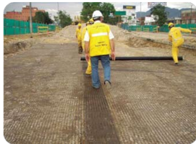
Troncal Transporte Masivo NQS Sur Tramo 1 Bogotá, 2005 (LBO 202)
