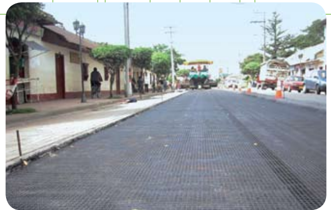
Intersección Cra. 53A - Calle 127 - Bogotá, 2008 (R 100)
