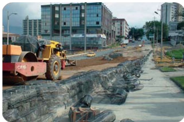
Puente Calle 14 - Pereira, 2003 (TT050 - TT070)
