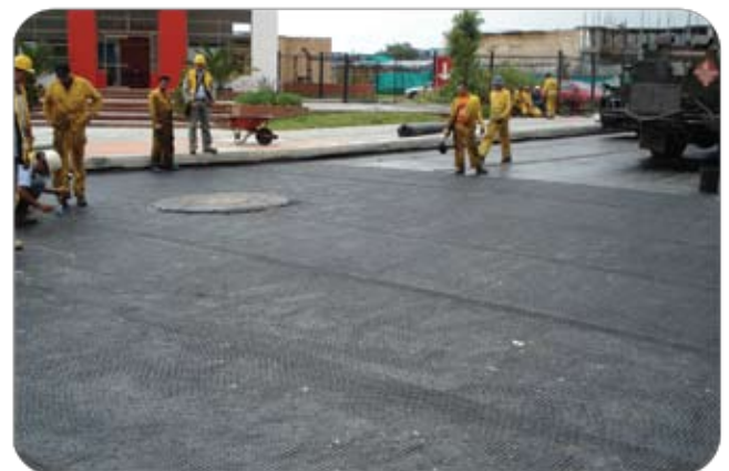
Intersección Cra. 53A - Calle 127 - Bogotá, 2008 (R 100)
