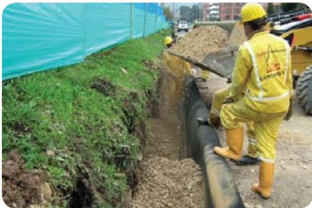
Avenida 9 Calle 127 - Bogotá, 2008 Geodrén Vial 100 mm / 1 mt
